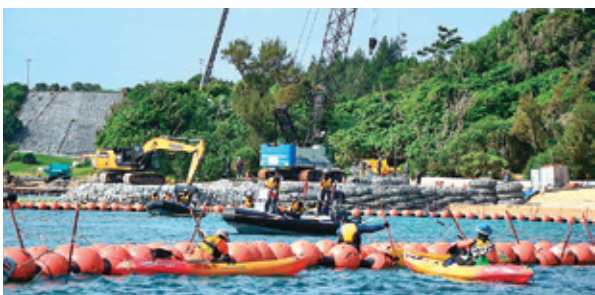
名護市辺野古の護岸工事
