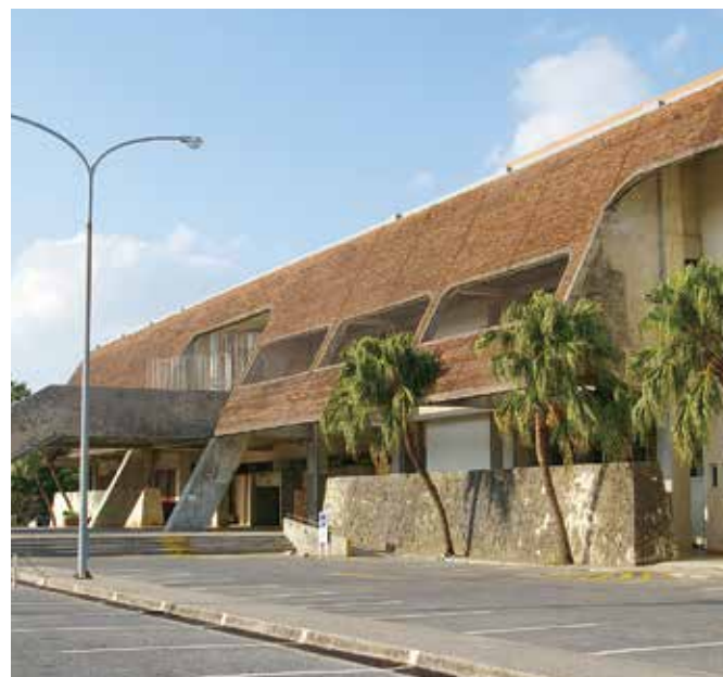
建築後46年が経過した那覇市民会館
