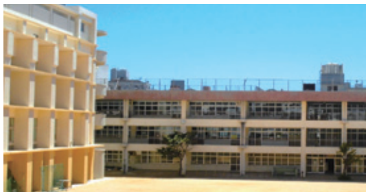
耐震補強を予定している市内小学校
