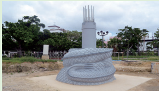
8月から工事が再開される若狭緑地の龍柱設置現場
