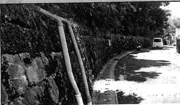
市道真地7号線は、真地小学校から真和志高校方面へ繋がる、市内でも数少ない急坂の道路である。通学路であり、生活道路でもある。左の石垣は建設からすでに50年は経過しているものと思われ、斜面から押されて膨らみと隙間ができています。その石垣を含む雑木林は私有地であるが、崖崩れ対策を自費で行うには巨額である。しかしその恩恵は地域住民が受けるのであれば、公共工事として対策すべきではないでしょうか。
