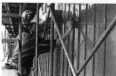
(左) 被災した奉神門屋根の復旧工事
