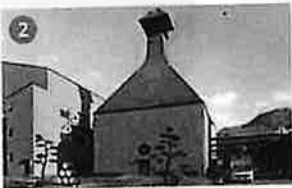
乾燥棟 (キルン塔)
