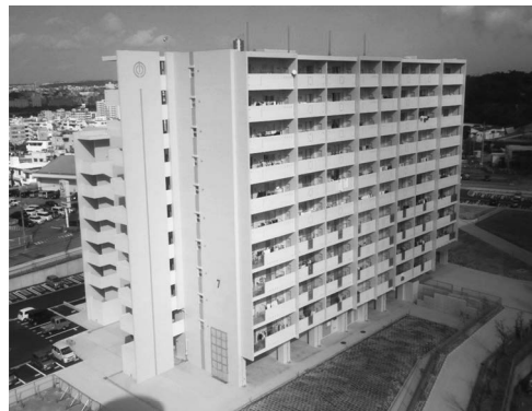
▲ 建替え後の宇米原市営住宅（第４期）
