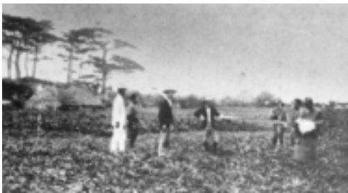
土地整理での測量作業風景
