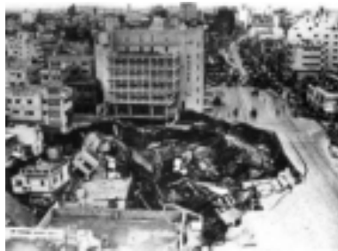
琉海ビル陥没事故 前島 11月26日
