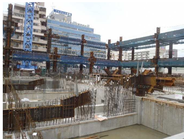
1階 大ホール 現況
