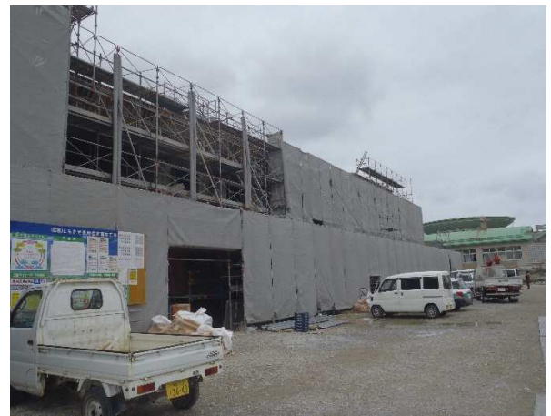
外部 北面 現況
