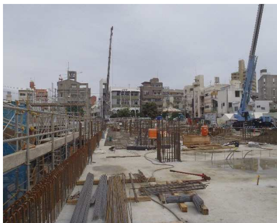
1階 南東部 現況
