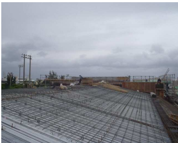
屋上屋根 躯体工事 現況
