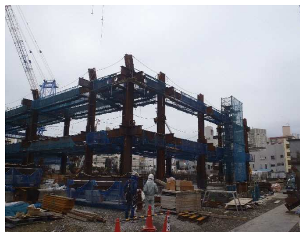
外部 南西面 現況
