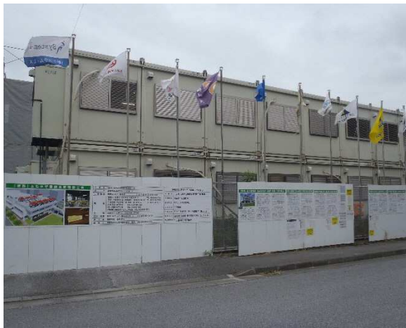
掲示物（各共同企業体含む） 建設業許可標識、労災保険関係成立票、 建退共制度の適用標識、施工体系図
