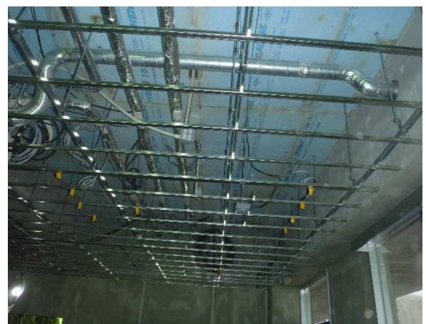
1階 仕上げ工事 現況
