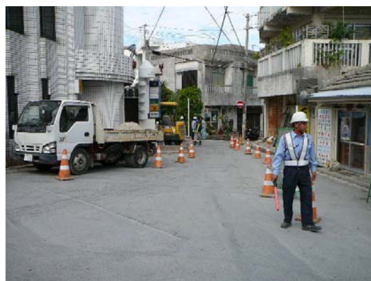
【作業箇所での交通誘導員配置】
