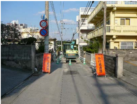
【作業箇所の歩行者通路確保状況】
