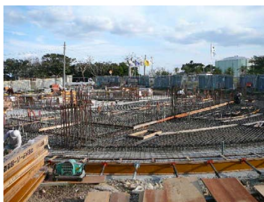
【納骨堂鉄筋組立状況】
