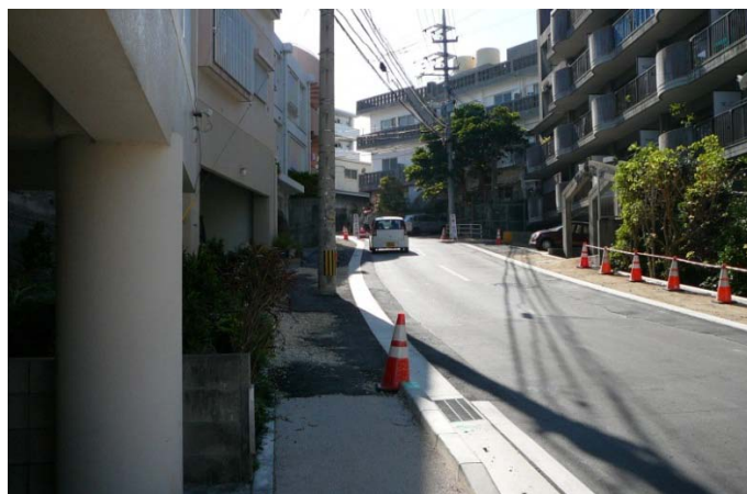
〔写真-1.歩道部全景〕
