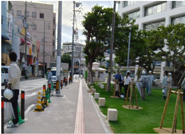
写真 8 現場説明状況
