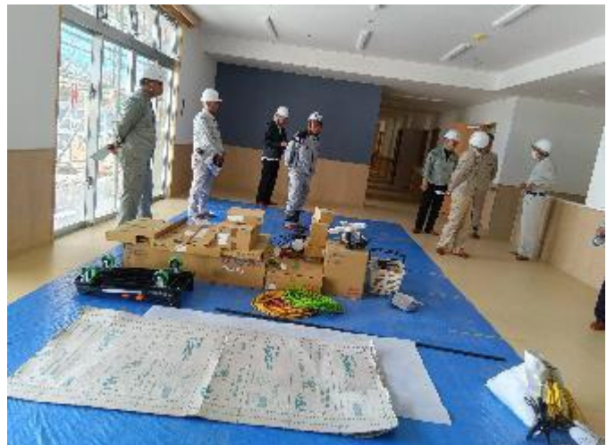
写真6 現場施工状況（室内）
