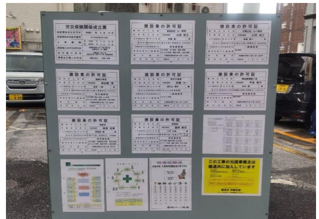
写真 11 工事看板設置状況
