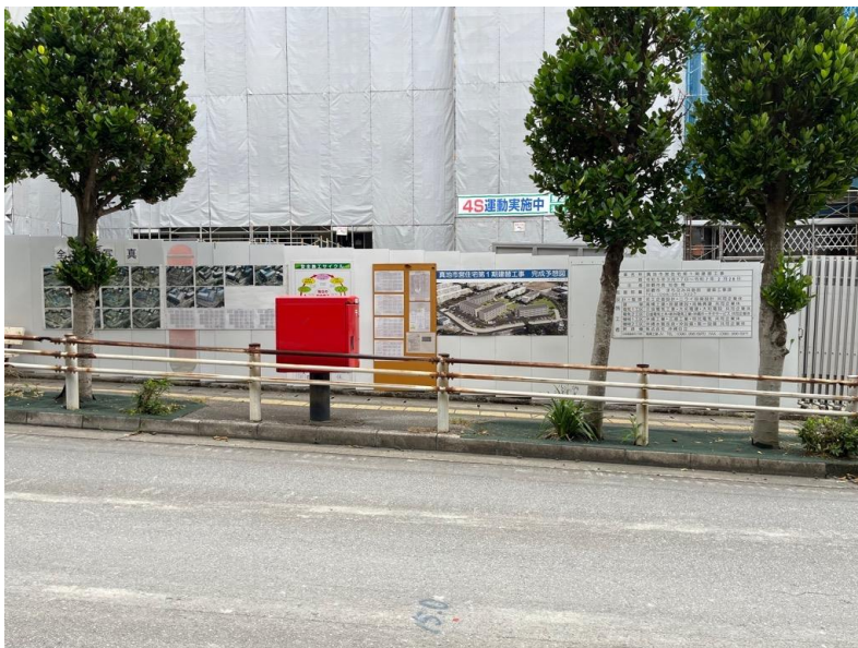
写真7 工事看板設置状況
