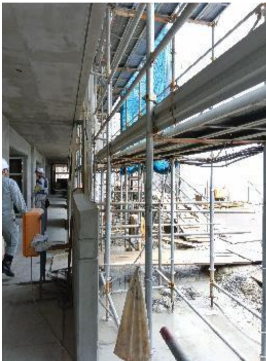
写真5 現場施工状況
