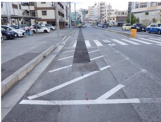
写真 14 現場施工状況
