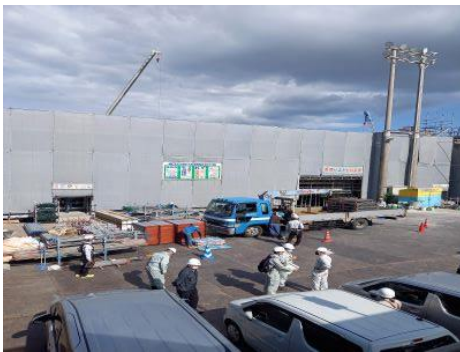
写真 1 現場正面全景
