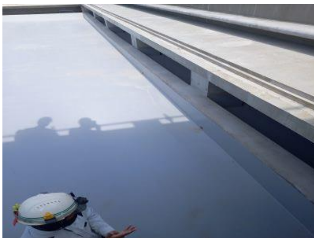
写真6 プールピット部 防水立ち上がり
