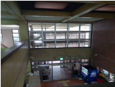
写真12 ホール上部建具改修
