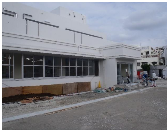
外部 南面 現況
