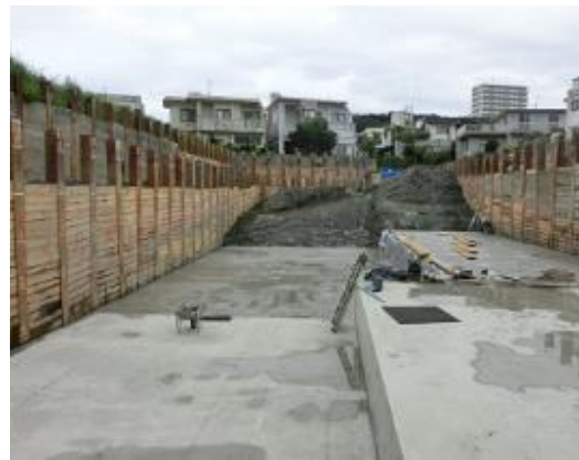
既施工部から施工箇所
