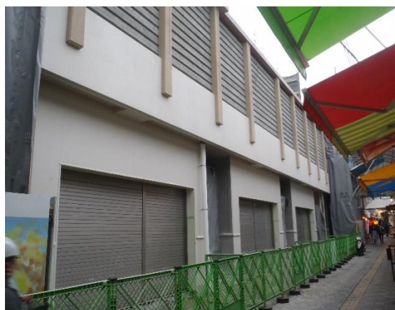
外部 北面 現況
