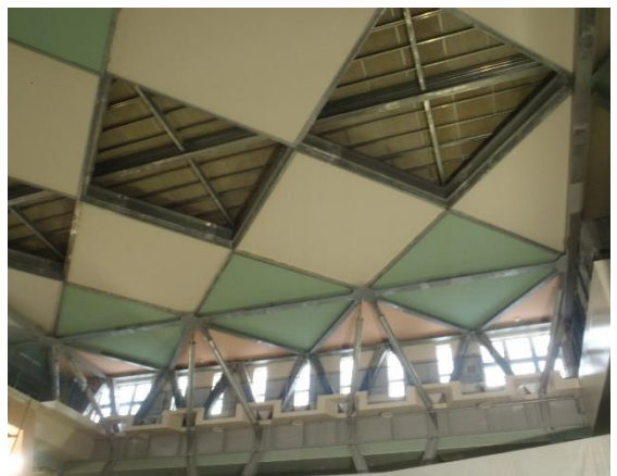
内部 吹き抜け部天井 現況
