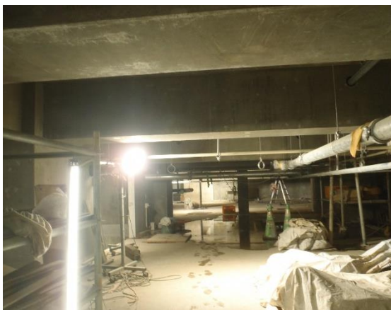
地下1階 ピット部 現況
