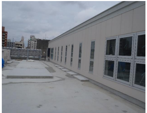
屋上 室外機置場 現況
