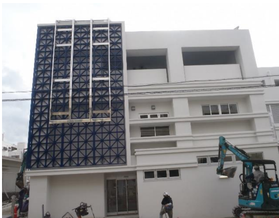
外部 北面 現況
