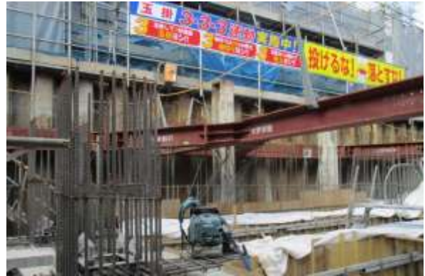
土留め工と防音シート
