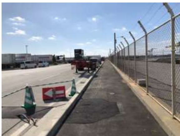
A・B結節点よりALine 舗装復旧後（南方向）
