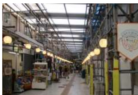
アーケード街の粉塵対策
