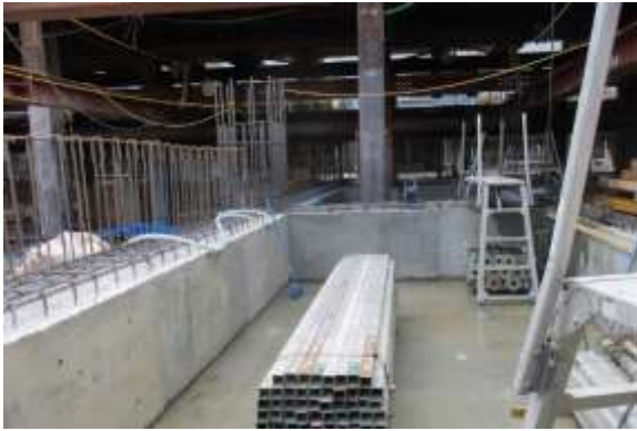
地下ピットの施工状況
