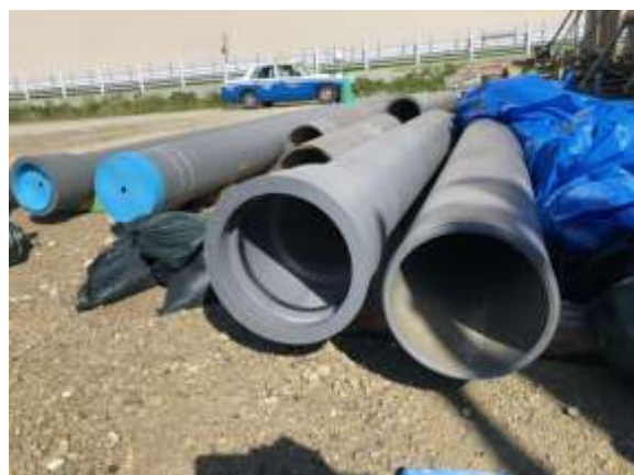
資材置き場での DX形ダクティル鉄管保管状況
