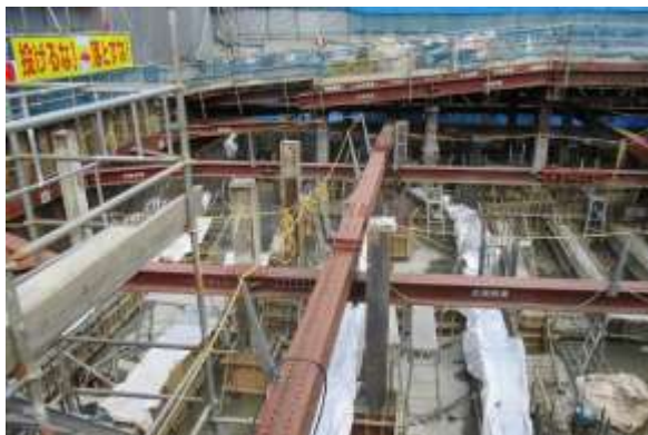
地下ピットの施工状況
