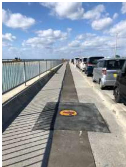
消火栓設置箇所とALine 舗装復旧後
