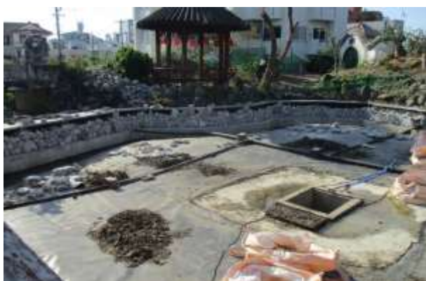
施工中の桃花溪
