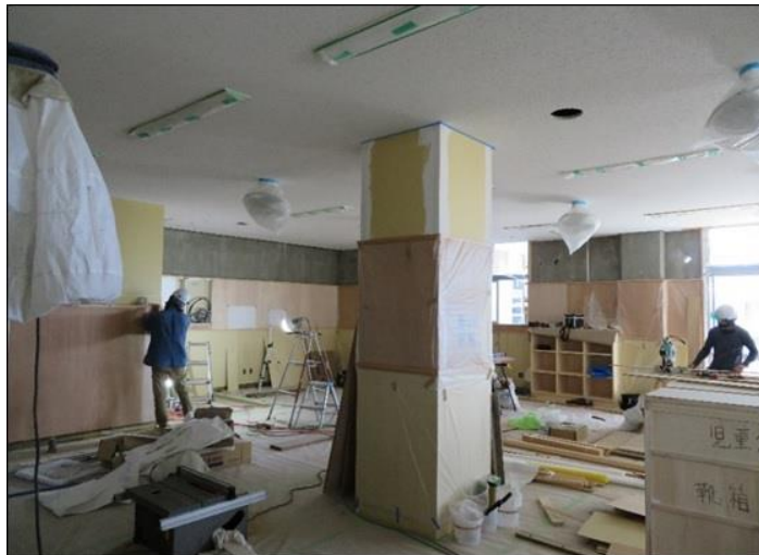
児童クラブ施工状況（内装・建具工事）
