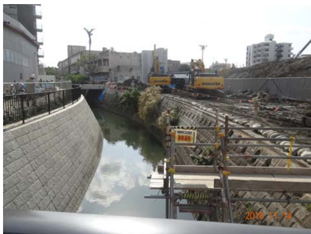
(護岸工 (地盤改良中))
