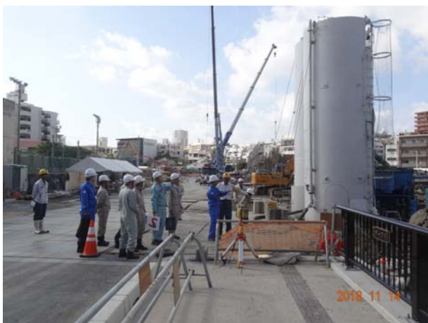
(現場調査写真)
