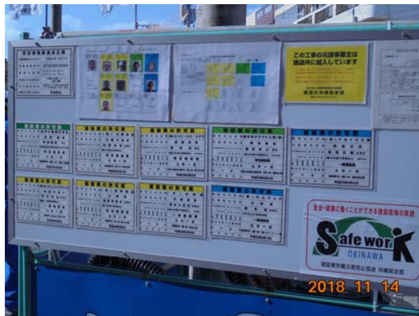
(護岸工 (地盤改良中))
