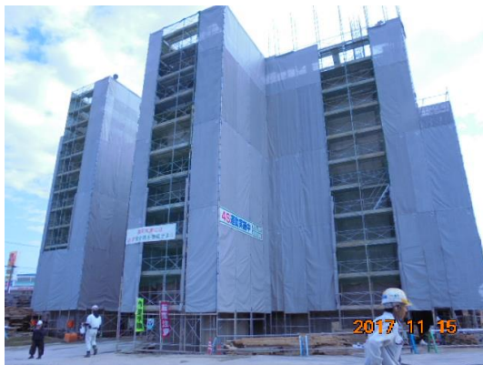
(現場調査写真)
