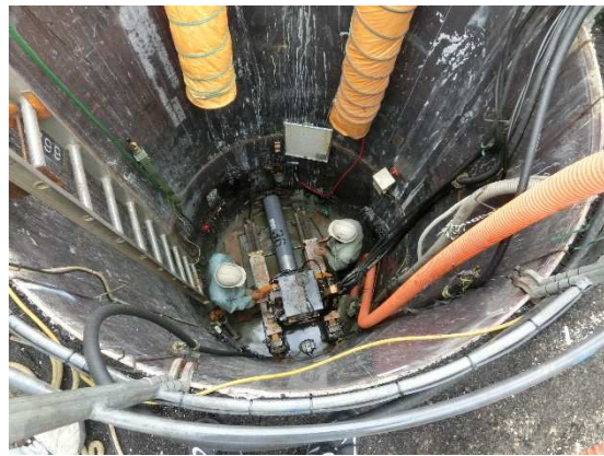
(写真-2 立坑内推進工施工中)
