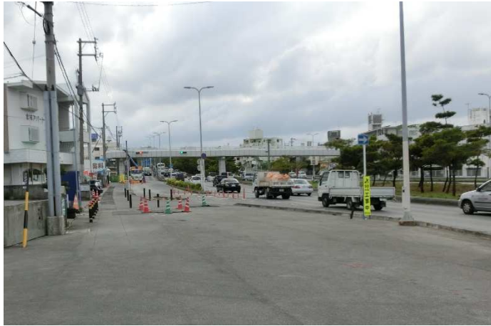
(写真-1 管路布設予定歩道)
