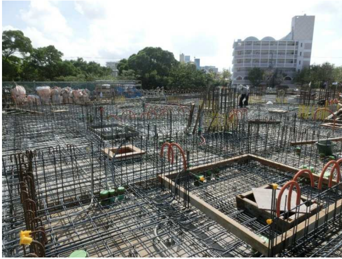
(写真-1 スラブ配筋状況)
