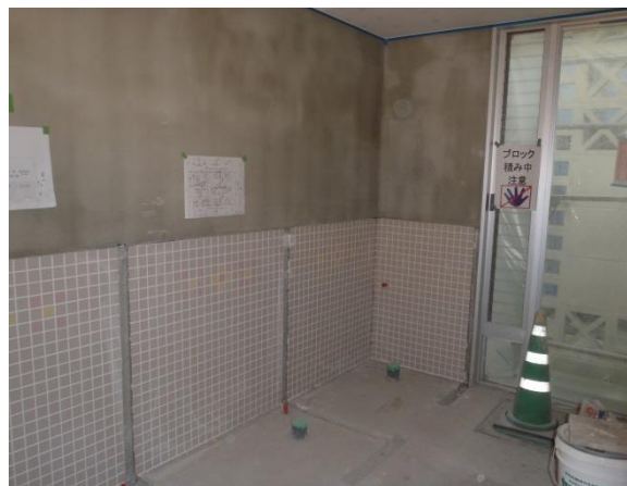
ポーチ仕上げ状況
