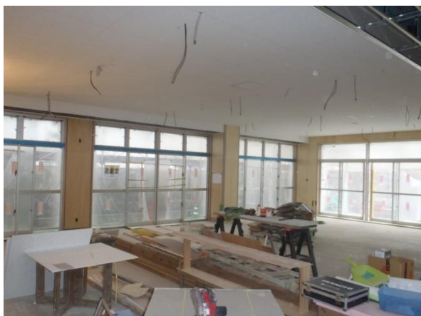
ホール仕上げ状況
