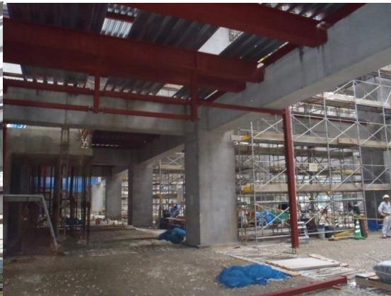
2階デッキ敷設状況
