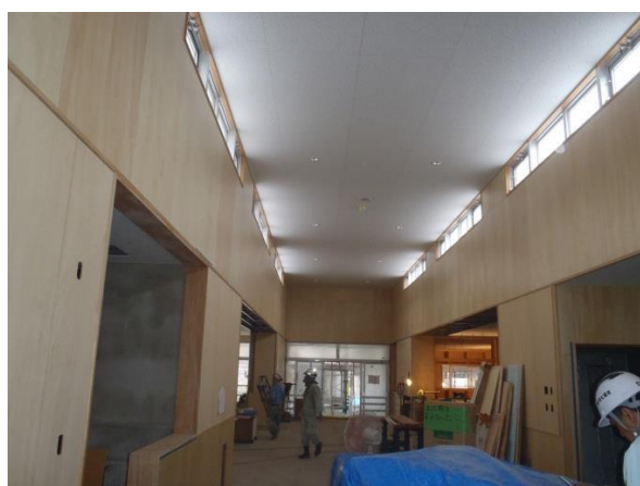
遊戯室仕上げ状況
