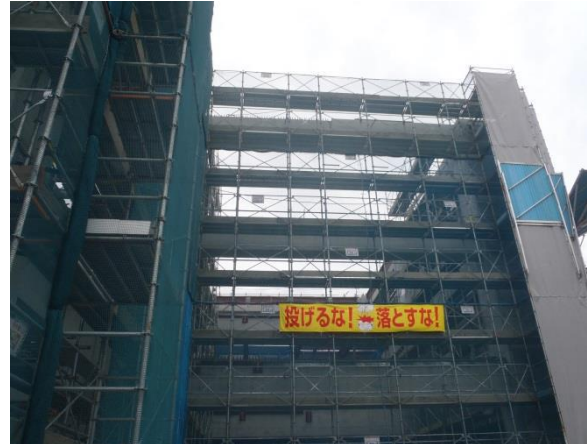
外部足場状況
