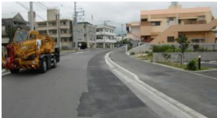
現場全景・布設替仮舗装部
