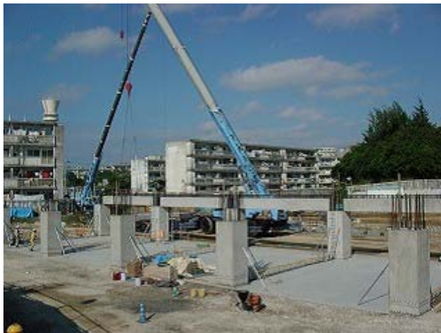
写真 - 12 P C 梁の架設状況
