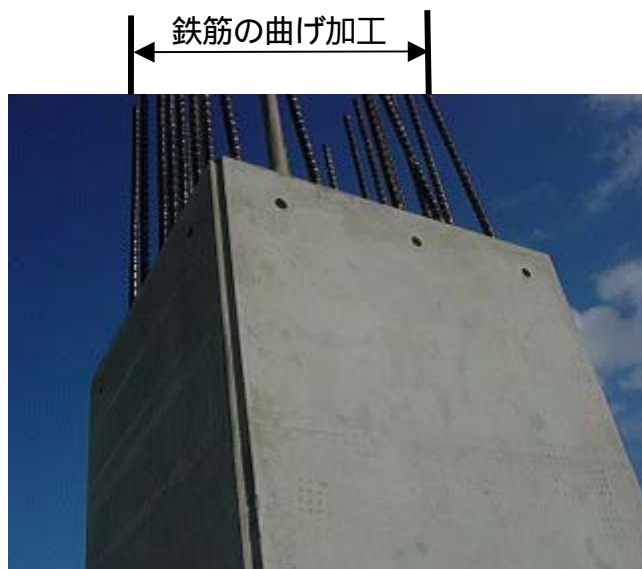
写真 - 10 PC柱上部の鉄筋曲げ加工
