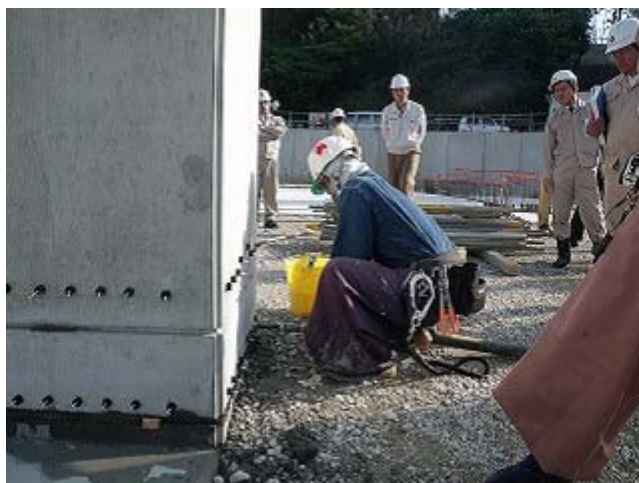
写真 - 11 PC柱下端のグラウト注入状況
