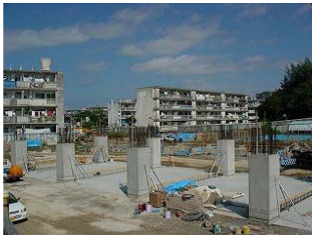
写真 - 9 P C 柱建込み状況
