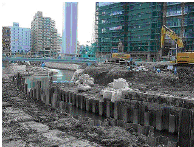
写真 - 5 安里地区市街地再開発事業の現状
