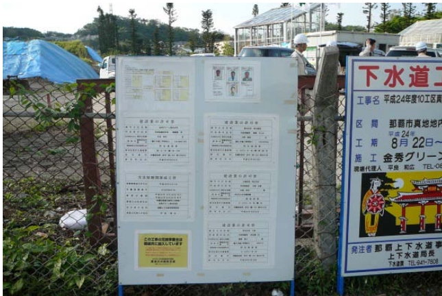
〔写真-6.標識の掲示状況・公衆の見やすい場所〕
