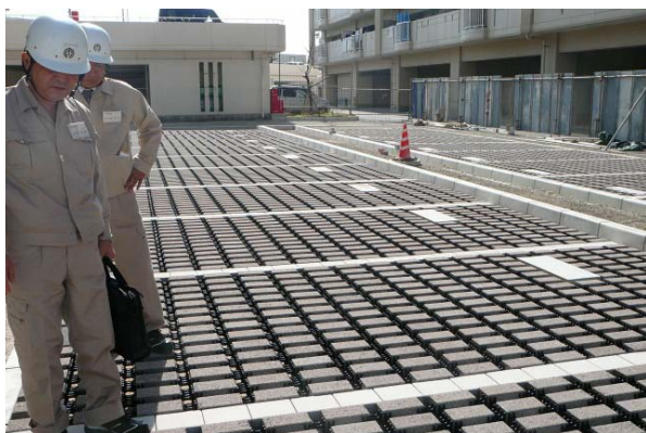
〔写真-3.植生駐車桟の駐車桟ブロック設置状況〕
