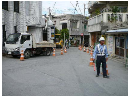
【作業箇所での交通誘導員配置】
