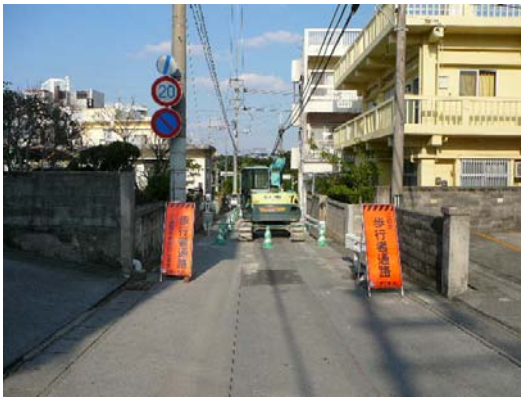
【作業箇所の歩行者通路確保状況】
