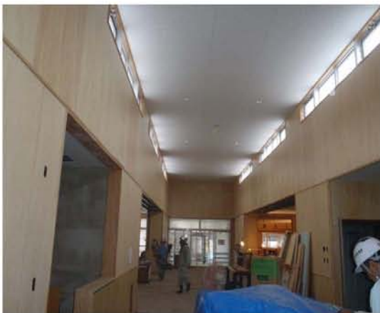
遊戯室仕上げ状況
