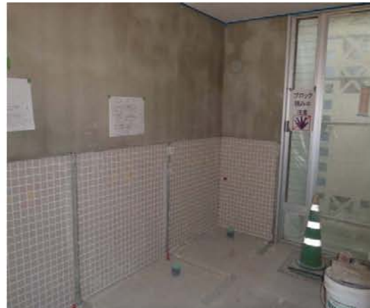
ポーチ仕上げ状況
