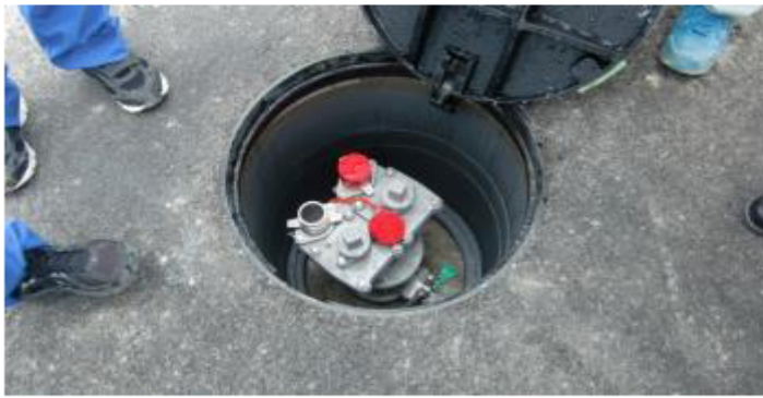
消火栓設置状況
