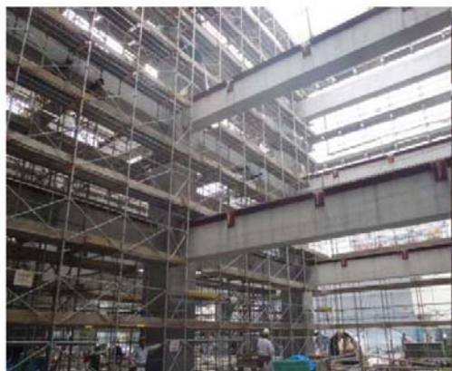
プレキャストプレストレスト コンクリート工事施工状況
