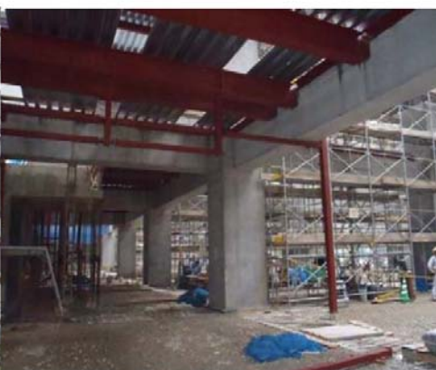
2階デッキ敷設状況
