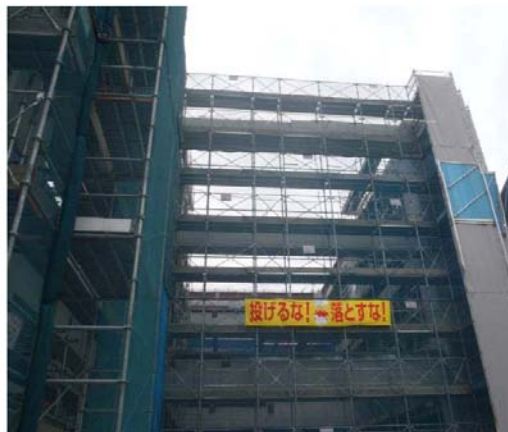
外部足場状況
