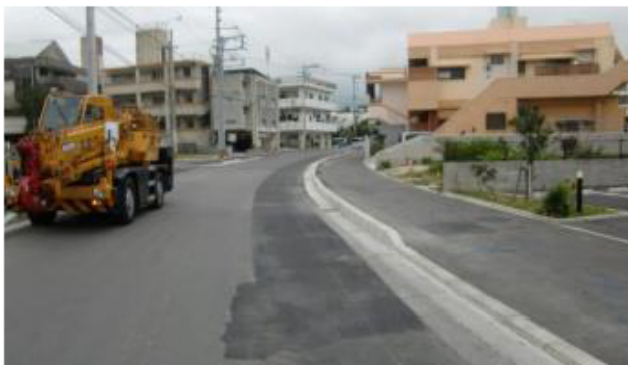
現場全景・布設替仮舗装部
