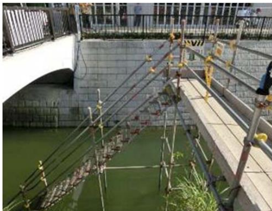
(護岸工 (地盤改良中))
