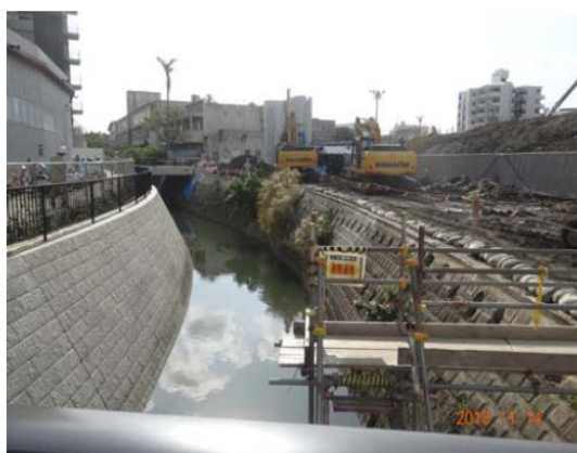
(護岸工 (地盤改良中))
