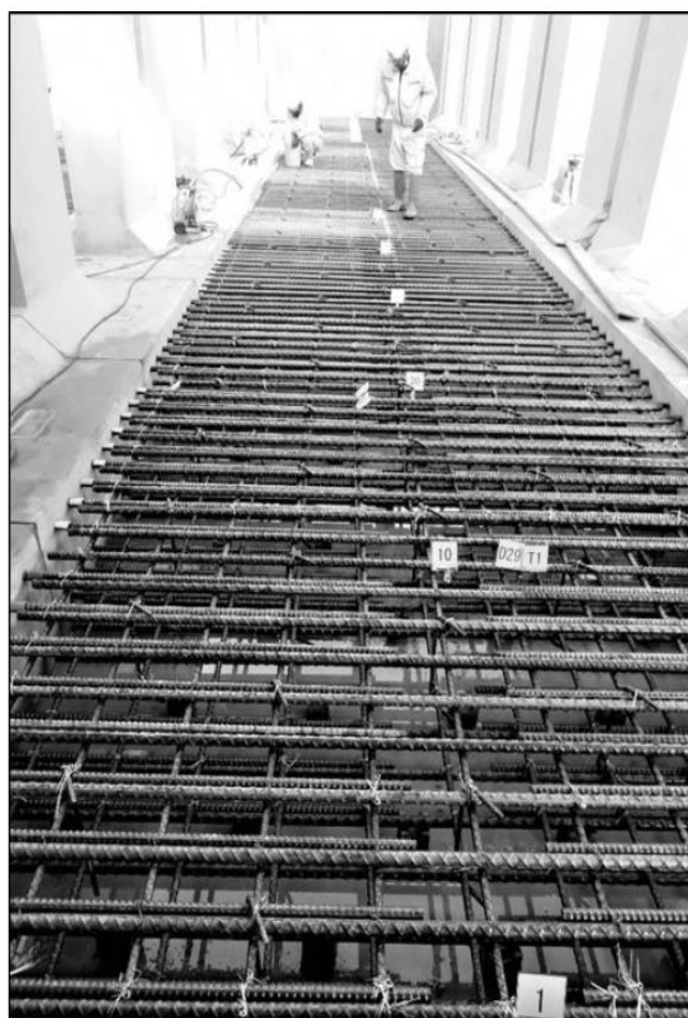
底版鉄筋組立状況
