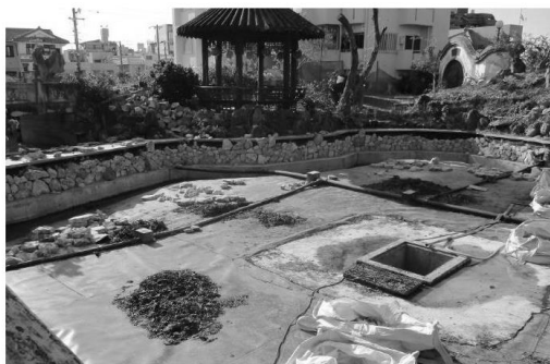
施工中の桃花溪
