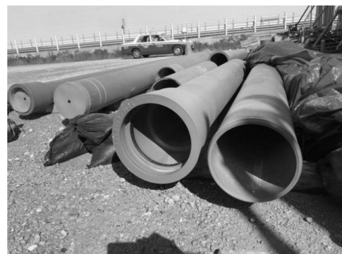
資材置き場での DX形ダクタイトル鉄管保管状況
