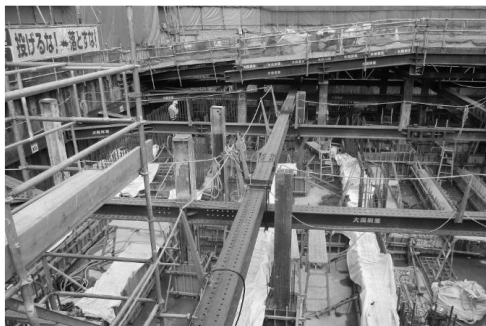
地下ピットの施工状況
