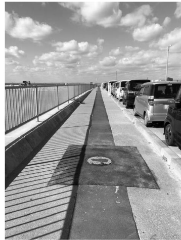
消火栓設置箇所とALine 舗装復旧後
