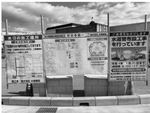
工事看板等の表示（全体）
