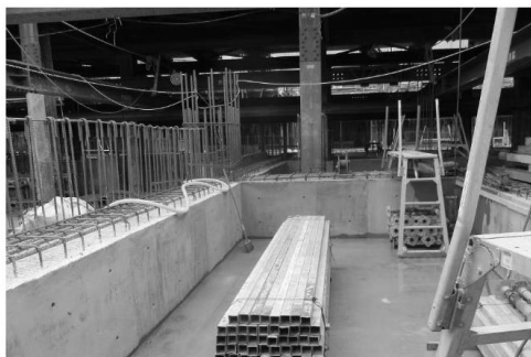
地下ピットの施工状況
