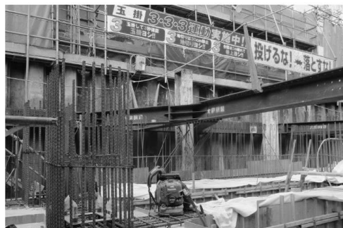
土留め工と防音シート
