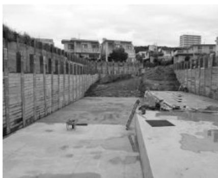
既施工部から施工箇所
