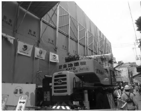
外部 東面 現況
