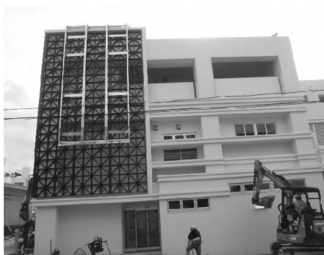
外部 北面 現況
