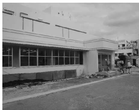
外部 南面 現況
