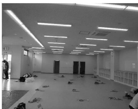
小禄支所 2階 事務室
