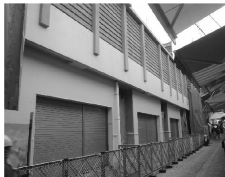
外部 北面 現況
