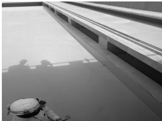
写真6 プールピット部 防水立ち上がり
