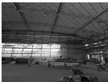
写真4 屋内運動場天井
