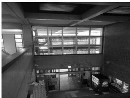
写真 12 ホール上部建具改修
