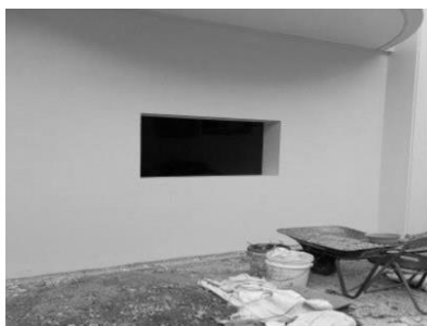
写真 10 耐震壁増設完了
