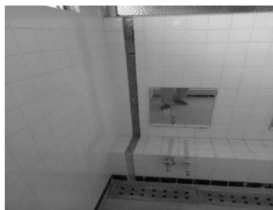
写真 11 浴室腰壁耐震スリット設置
