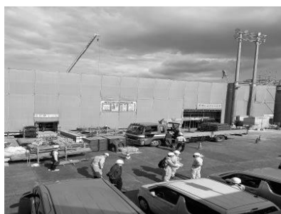
写真 1 現場正面全景
