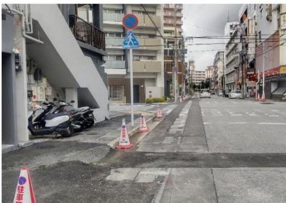
写真 9 現場施工状況
