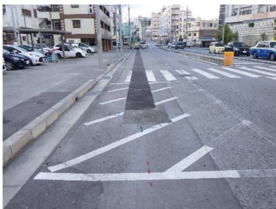
写真 14 現場施工状況
