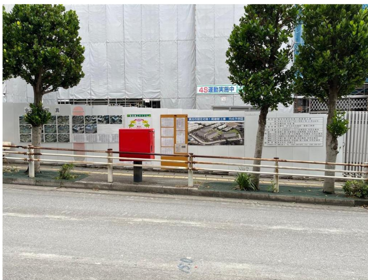
写真7 工事看板設置状況
