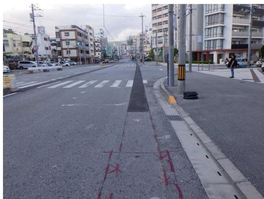
写真 12 現場施工状況
