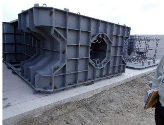
写真18 型枠外景及び均しコンクリート
