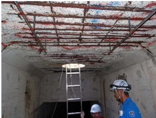
写真3 更生前の劣化損傷状況
