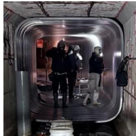
写真4 ライニング位置決め用金具設置
