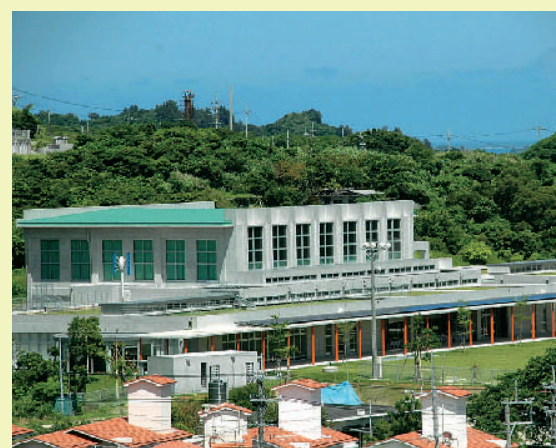
会議室や研修室のほか、トレーニングルーム、岩盤浴、サウナなどを備えた複合施設・環境の杜ふれあい落成した(30日)
