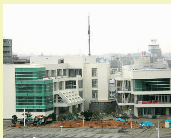
新庁舎は、災害時には水道ライフライン確保のための防災拠点としての役割を担うことが期待されている(29日)
