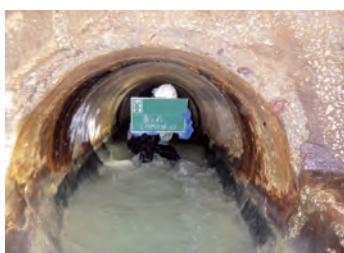
長寿命化(更生工法) 施工前 久茂地地区
