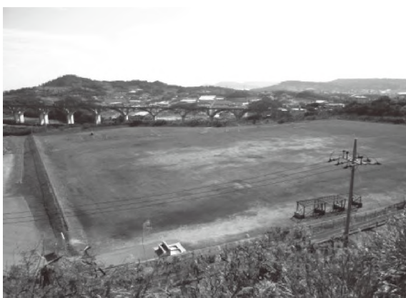
スポーツ広場（監査人視察時）
