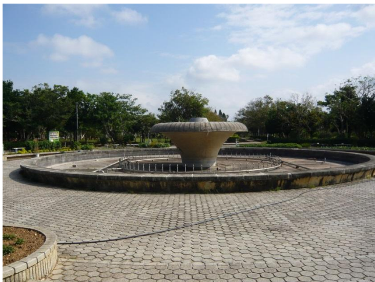
漫湖公園内の噴水施設、現在は夏場も含めて稼働していない。
