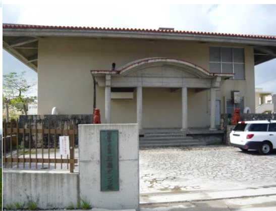
（石嶺ポンプ場）
