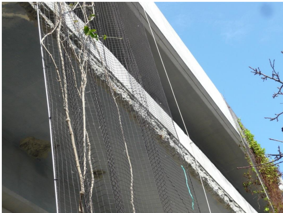
上部が剥離し、補修した箇所
