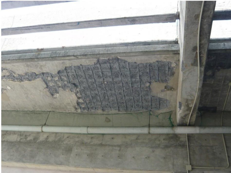
上部が剥離し、補修した箇所
