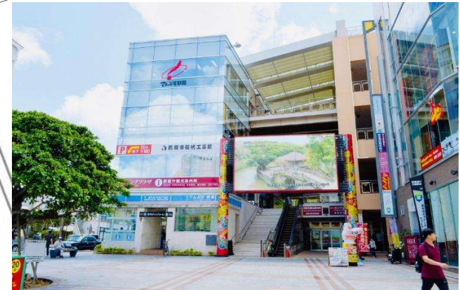
【イメージ画像】 広告塔の設置
