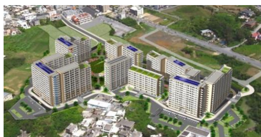
大名市営住宅
