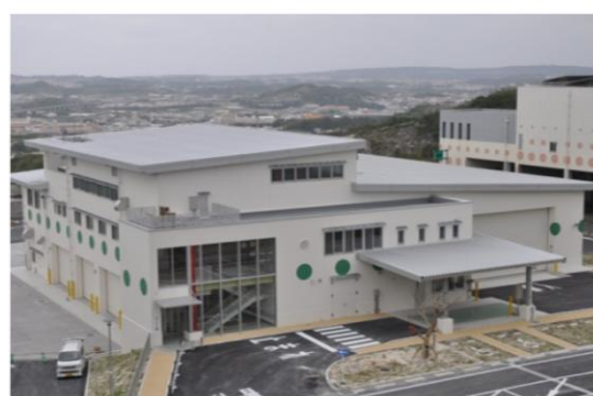
リサイクル施設 (エコまる那覇リサイクル棟) Recycling Facility(Ecomaru Naha Recycle building)
