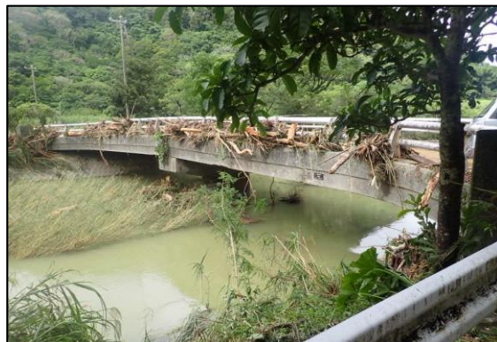
橋の欄干に引っかかる流木（国頭村）
