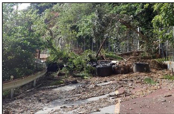
土砂崩れ（県道14号）
