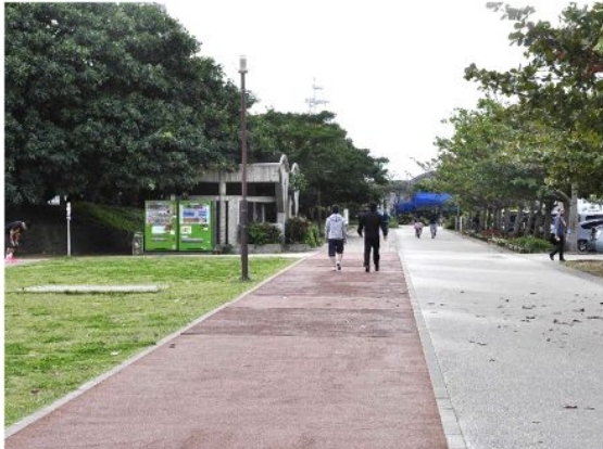
利用者の負担軽減のため、ゴムチップ舗装を行った事例 【那覇市：新都心公園】
