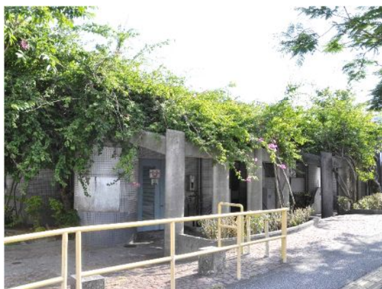
屋上部を緑化することで公園の持つ自然景観に配慮した事例 【那覇市：松山公園】
