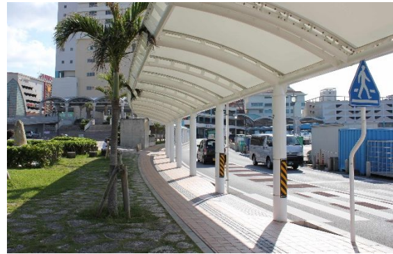
ターミナルの玄関口として緑化を行いつつ、遊歩道にシェルターを設け、雨天時等への配慮をしている事例【那覇市：那覇港泊ふ頭地区】
