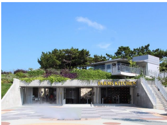
屋上部を緑化することで、公園の持つ自然空間と調和させた建築物 【那覇市：クニダテラス(松山公園内)】 <第19回 那覇市都市景観賞>
