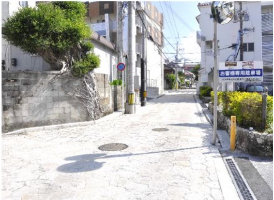
舗装に琉球石灰岩を活用することで、歴史的な街並みを創出している事例【那覇市:首里大中町】
