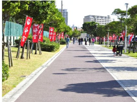
利用者の負担軽減のため、ゴムチップ舗装を行った事例 【那覇市：奥武山公園】
