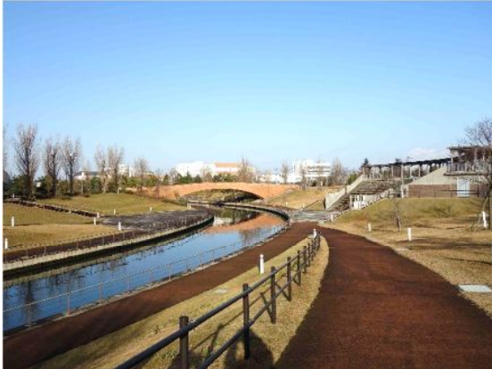
公園全体の色彩を茶系とし、暖かみを感じることができる空間を演出した事例【富山県: 富岩運河環水公園】
