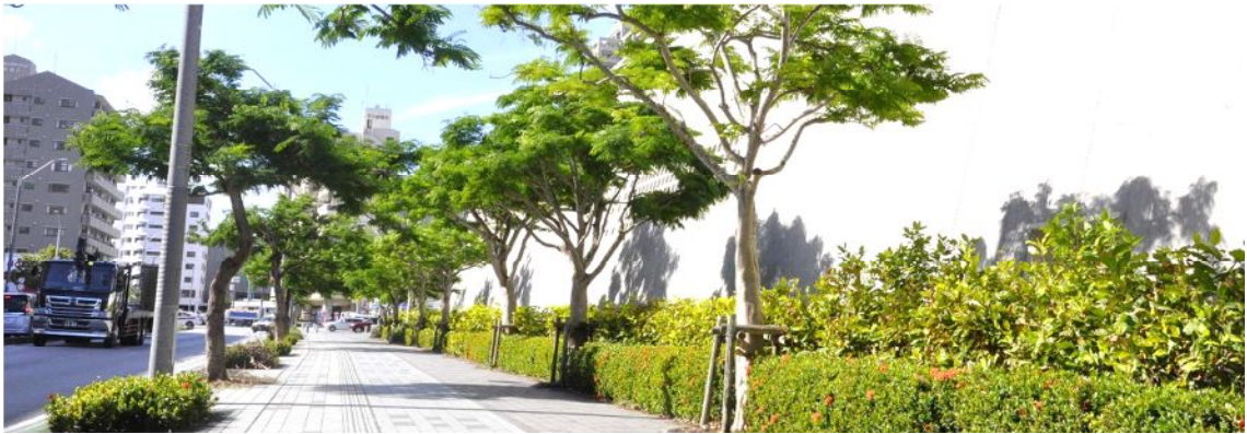
道路と建築物の間に中木と花木を植栽し、壁面の圧迫感を軽減することで良好な沿道景観を演出した事例【那覇市：沖縄県立博物館・美術館】
