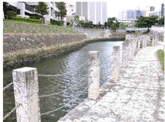
支柱を周辺の素材と調和させ、防護柵に鎖を活用することで、透過性に配慮した事例【那覇市:さいおんスクエア・安里川】
