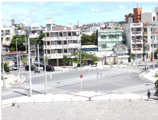
交差点の隅切り部(歩道部の幅員)を大きくとることで見通しの良い交差点を形成【那覇市：農連中央市場周辺】
