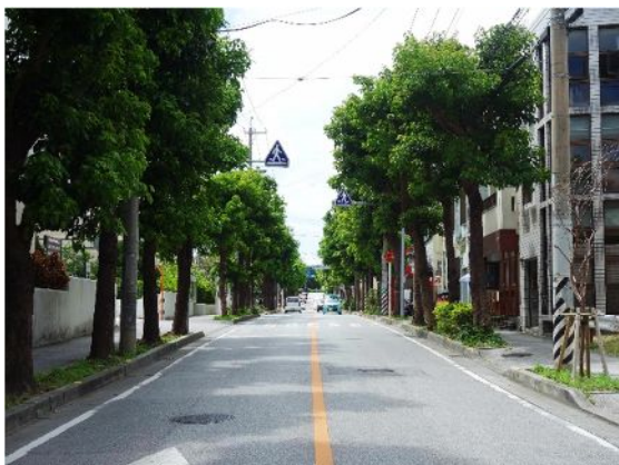
緑のトンネルを思わせる美しい道路空間を形成している事例 【那覇市：裁判所通り】<第9回 那覇市都市景観賞>
