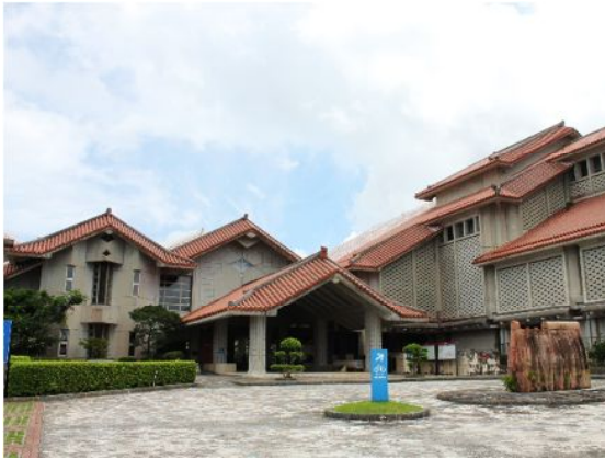
屋根に赤瓦を活用し、全棟の屋根の形状を勾配屋根で統一させた事例 【南風原町：沖縄県公文書館】
