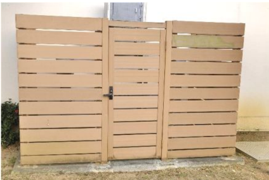
周辺の景観に配慮し、木調のルーバーで目隠している事例 【那覇市：さいおんスクエア】
