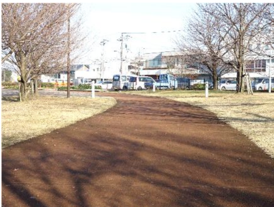
縁石を設けず段差を解消した事例 【富山県：富岩運河環水公園】
