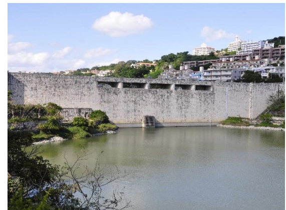
周辺の景観と調和させた琉球石灰岩の構造物 【那覇市：金城ダム】
