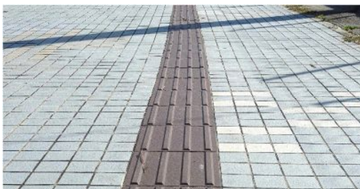
周辺の舗装と明度を変えた点字ブロックの事例 【南風原町：南風原町役場周辺】
