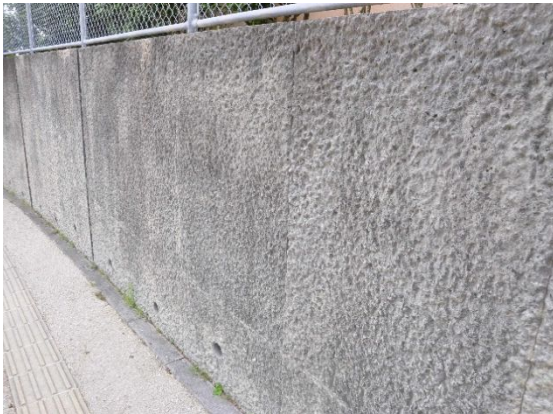
擁壁の表面に凹凸をつけ、のっぺりとした印象を軽減した事例 【那覇市：泊小学校周辺】
