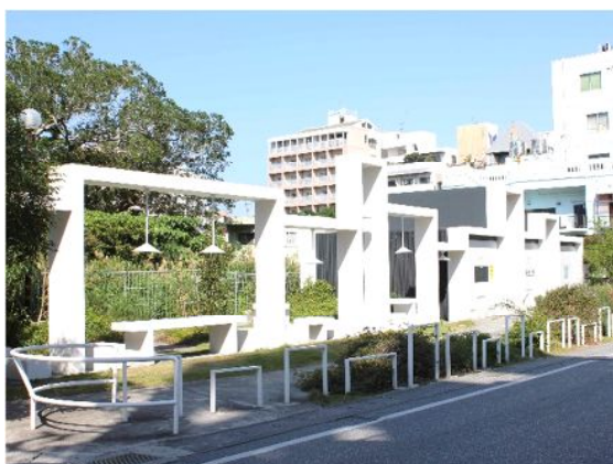
休憩施設と一体化したトイレ。公園のエントランスの役割も果たしている 【那覇市：緑ヶ丘公園】
