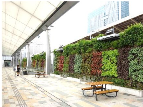
建物と建物を繋ぐ連絡通路の壁面を緑化した事例 【東京都：東京駅】
