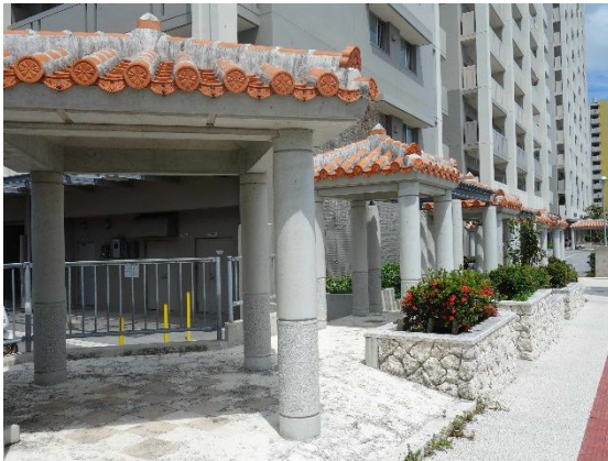
赤瓦の屋根を活用することで情緒ある空間を演出している。また、道路側を緑化することで、潤いある空間を創出した事例 【那覇市：石嶺市営住宅】
