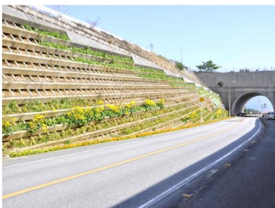
周囲の擁壁と一体化させ、擁壁部に植栽し、通行車への配慮も行っている事例【南城市：ニライカナイ橋周辺】
