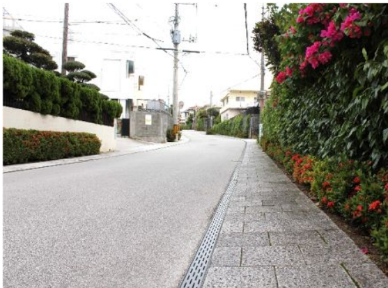
スリット側溝により、道路全体の舗装がすっきりとしたイメージを創出した事例【浦添市：浦添グスク・ようどれ館前】
