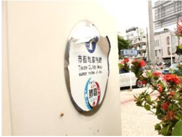
公共サインの剥離
