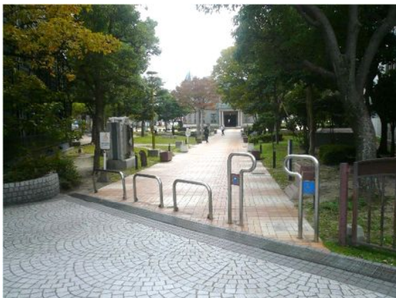
オートバイの進入を防ぐように配慮した進入路 【福岡県：天神中央公園】
