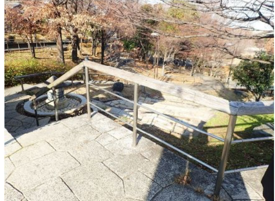
手摺りに木材を活用することで、周辺の自然景観に配慮した事例 【東京都: 清水坂公園】
