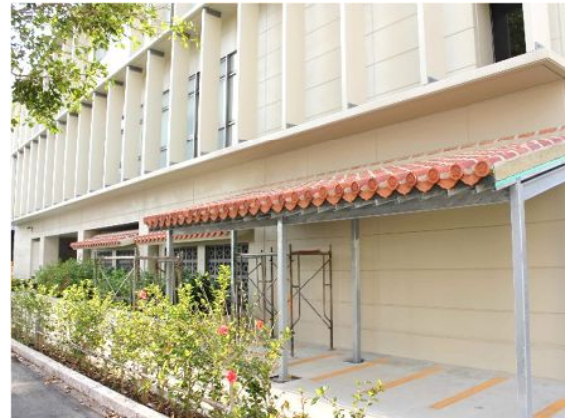
赤瓦を部分的に活用した事例 【那覇市：沖縄県市町村職員研修センター】
