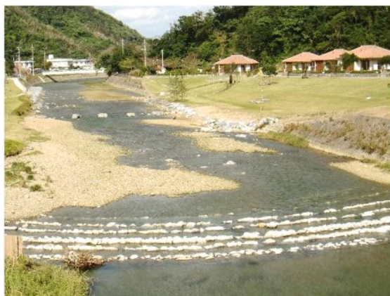
緩やかな傾斜の護岸の背後部を公園と一体化させ、河川の自然空間と公園の魅力を合わせた事例【国頭村：奥川】
