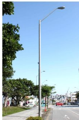
車道照明の下部を琉球石灰岩風にデザインされた事例、また、その上部は貼り紙が容易に行えないように対応した事例【那覇市：新都心周辺】
