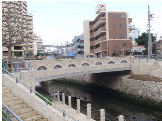
側面部に琉球石灰岩を活用し、景観に配慮した事例 【那覇市：あがり橋】
