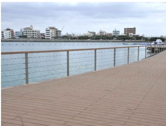
ビーム状の防護柵とし、透過性に配慮した事例 【北谷町:フィッシャリーナ】
