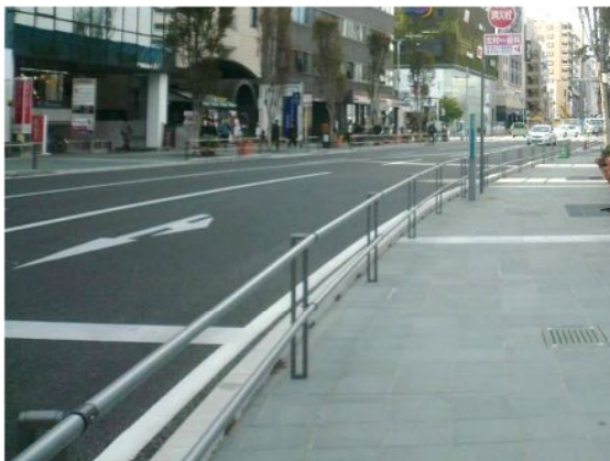
防護柵をビーム状にすることで、透過性を向上させた事例 【福岡県：博多駅前通り】
