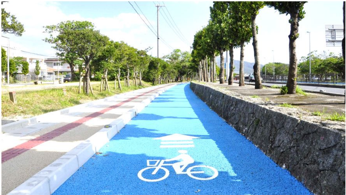
縁石と植栽を活用し自転車道と歩行者専用道路を分離した事例【名護市：宮里・21世紀の森公園付近】
