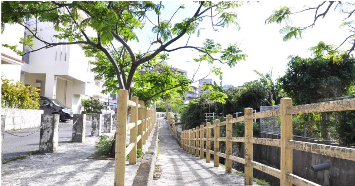
住宅地の間を流れる雨水路に遊歩道を設けて親しみと潤いのある水辺空間を創出している事例
