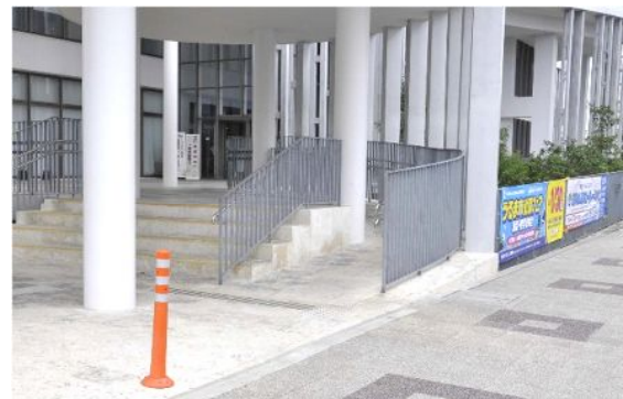
庁舎の入口部までのスロープを整備し、車いす利用者も利用しやすいように配慮している事例【うるま市：うるま市役所】
