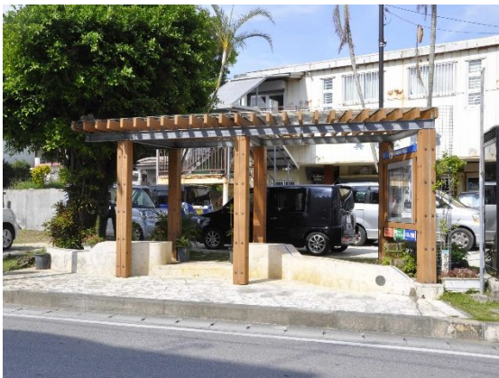
木と琉球石灰岩を活用したバス停。背後の真地公民館と一体的に整備した事例【那覇市：識名園前バス停】 <第13回 那覇市都市景観賞>
