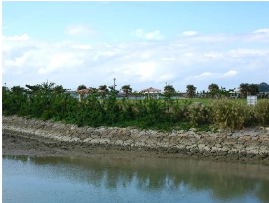
緩やかな勾配の護岸とし、その背後に緑地とオープンスペースを設けた事例【豊見城市：豊崎海浜公園】
