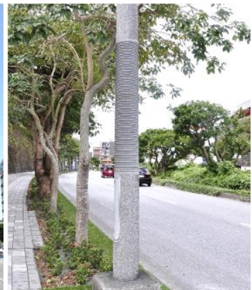
車道照明の下部を琉球石灰岩風にデザインされた事例、また、その上部は貼り紙が容易に行えないように対応した事例【那覇市：新都心周辺】
