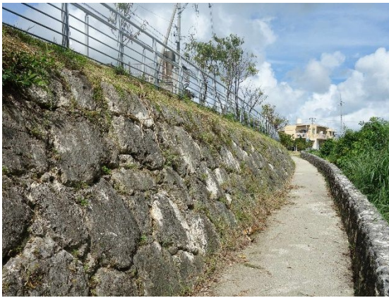
琉球石灰岩を活用した護岸【南風原町:国場川】
