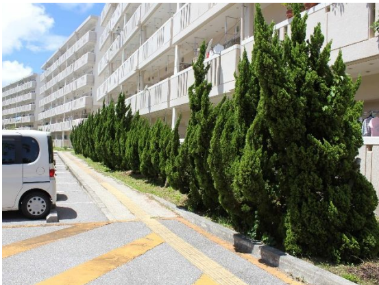
一階部分のベランダの目隠しに植栽を用いた事例 【豊見城市：豊見城団地県改良住宅】
