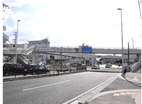
交差点整備の際に周辺の歩道と一体的に整備を行った事例 【宜野湾市：我如古交差点】
