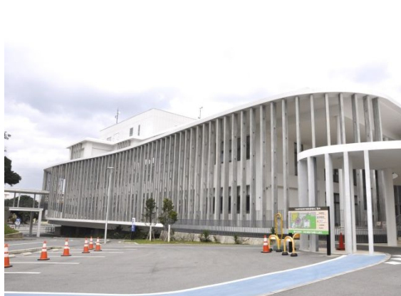
縦型のルーバーを活用し、壁面の圧迫感を軽減している事例【うるま市：うるま市役所】
