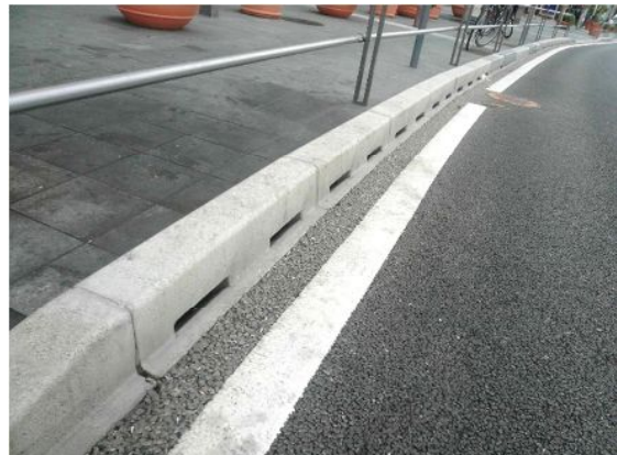
縁石の下部に側溝を設けた事例【福岡県：博多駅前通り】
