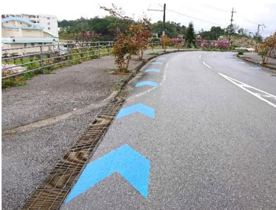
車道部に矢羽根型の自転車専用道路標示を行い、車道部と自転車専用部を分離した事例【名護市：宇茂佐の森地内】
