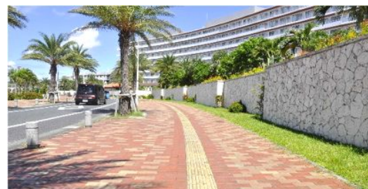
周辺の舗装に配慮した黄系の点字ブロックの事例 【北谷町：フィッシャリーナ】
