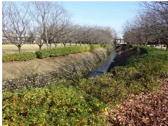
植栽による柵を設けることで周辺の景観にも配慮している事例 【富山県：稲荷公園】
