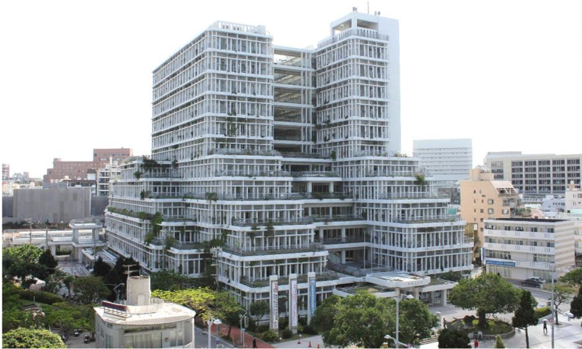
自然光や自然風を取り込みやすいつくりとし、圧迫感軽減に配慮されたデザインとなっている。また壁面緑化により「亜熱帯庭園都市」なはの景観』をイメージした建築物となっている【那覇市：那覇市役所】
