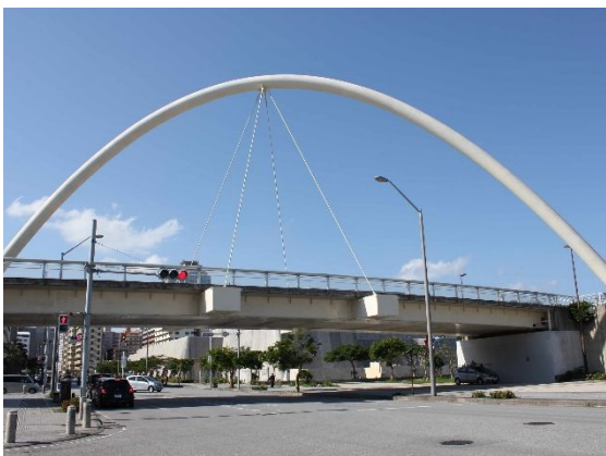
地域のランドマークとなっている歩道橋(おもろ天空橋) 【那覇市：新都心公園周辺】
