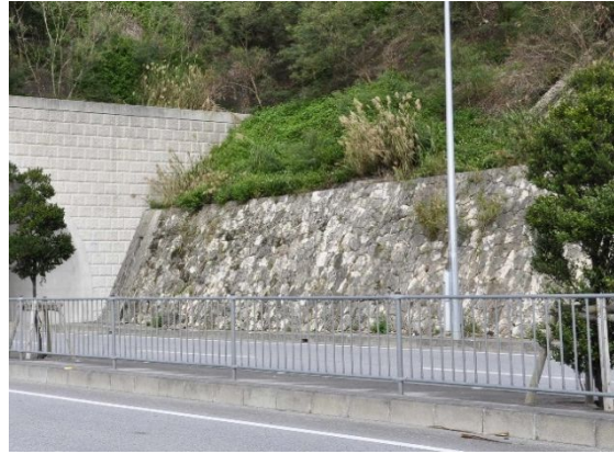
琉球石灰岩を活用した事例 【南風原町：高津嘉山トンネル周辺】
