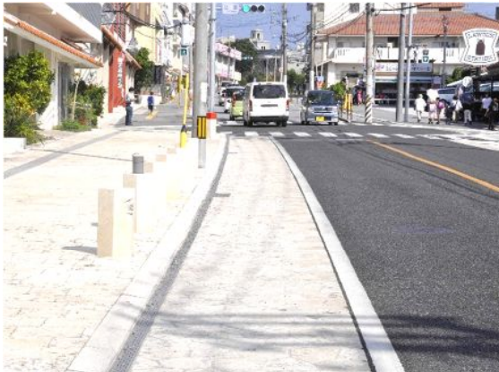
停車帯の舗装に琉球石灰岩を活用するとともに、歩道との段差を解消し歩きやすい整備がなされている事例【那覇市：龍潭通り】
