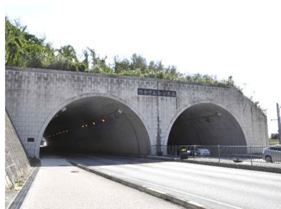
坑口部を琉球石灰岩で仕上げ、良好な景観を創出した事例 【南風原町：つかざんトンネル】
