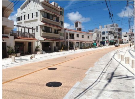
周辺の歴史景観に配慮し、車道のアスファルト面に歩道舗装と同系色の遮熱性塗装を用いた事例【那覇市:龍潭通り】
