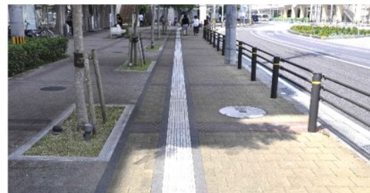
周辺の舗装に配慮し、点字ブロックの側に縁取りを設けた事例 【那覇市：沖縄県南部合同庁舎前】
