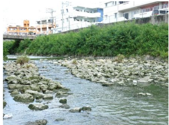
落差工を数段に分けて設け、その周りを自然石で周辺の景観に配慮した魚道の事例【南風原町：国場川】
