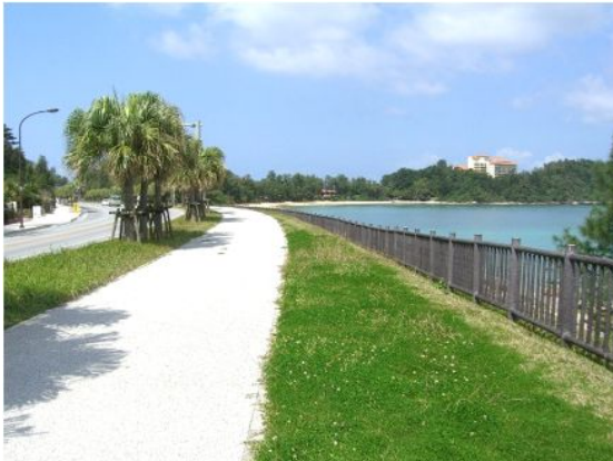
周辺の自然景観と調和を図るため、歩道に石紛風舗装(脱色アスファルト舗装)を用いた事例【名護市:国道58号】
