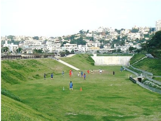
緑のオープンスペースを設け、多目的に有効利用を図っている事例 【那覇市：真嘉比遊水地】
