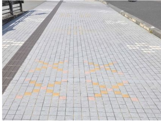
舗装にかすりの模様を施した事例 【南風原町：南風原町役場前】
