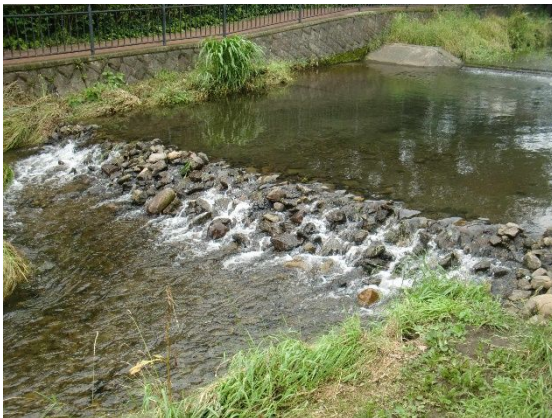
緩やかな落差工を設け、周辺の景観に配慮し自然石を活用した魚道の事例【東京都：落合川】
