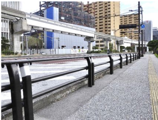
防護柵を横ビーム状とすることで透過性を向上させ、ドライバーへの圧迫感を軽減している。また、丸みのあるボルトを使用し、ボルトを内側に設置することで、親和性を向上させ、歩行者への安全性にも配慮している事例【那覇市：那覇東バイパス】
