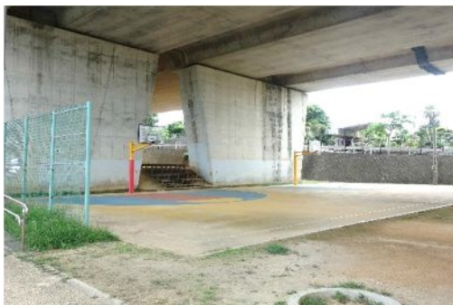
橋桁下を公園として活用している事例 【南風原町：花・水・緑の大回廊公園】
