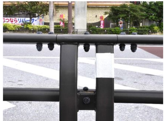
防護柵を横ビーム状とすることで透過性を向上させ、ドライバーへの圧迫感を軽減している。また、丸みのあるボルトを使用し、ボルトを内側に設置することで、親和性を向上させ、歩行者への安全性にも配慮している事例【那覇市：那覇東バイパス】
