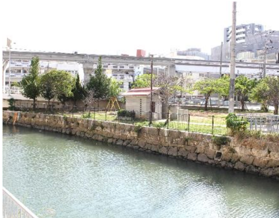
河川分流部を活用した公園 【那覇市：前島南公園】
