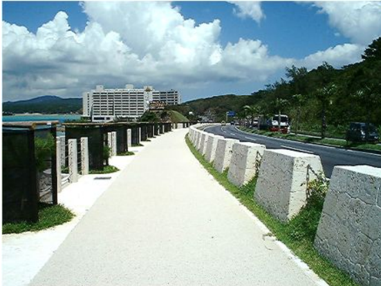
周辺の自然景観と調和を図るため、歩道に石紛風舗装(脱色アスファルト舗装)を用いた事例【恩納村:国道58号】
