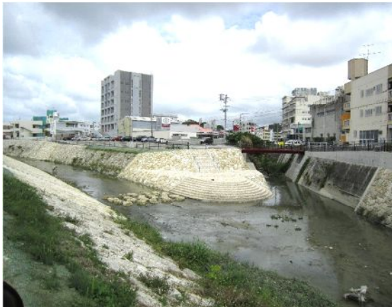
河川合流部に休憩広場を設けた事例。水辺にふれあえる場として整備した事例【南風原町：国場川】
