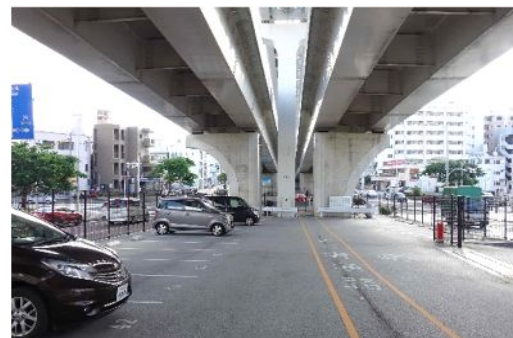
橋梁下をパーク＆ライドの駐車場として活用している事例 【那覇市：安里交差点周辺】
