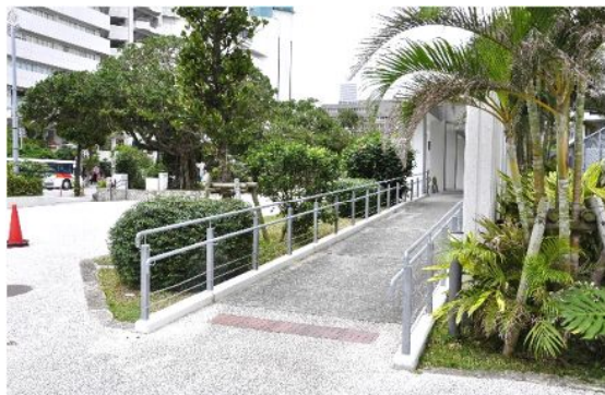
車いす利用者が通りやすい幅員を確保するとともに、その両脇を植栽することで、景観に配慮している事例【那覇市：那覇市役所】
