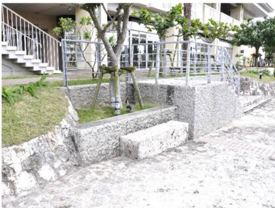
周辺の素材と調和させ、擁壁部と一体的に整備したベンチ 【那覇市:カフーナ旭橋】
