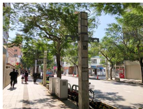
▲ 牧志中央線（無電柱化）
