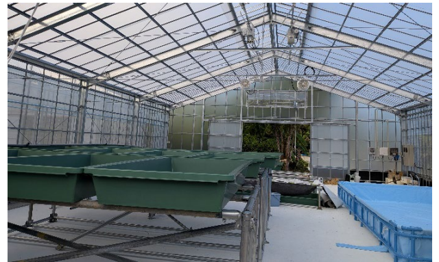
魚の排泄物を栄養源として水耕栽培をする ビニールハウス
