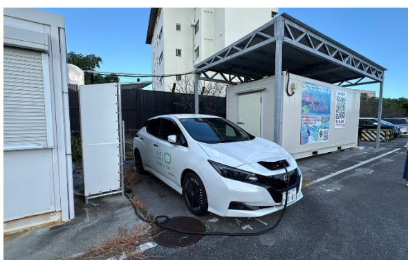
陸上養殖施設に電力を供給する電気自動車
