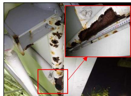
写真-1.4 県庁前駅 B 橋(自由通路) 屋根梁部の断面欠損
