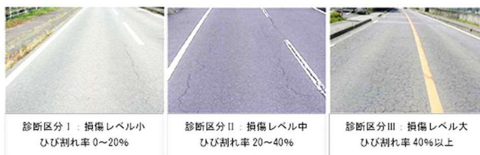
参考写真-1 ひび割れ状況と診断区分※
