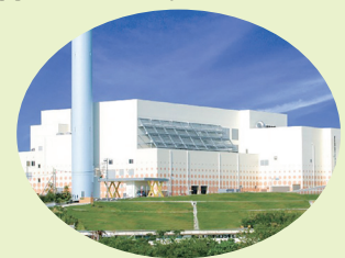
那覇・南風原クリーンセンター
